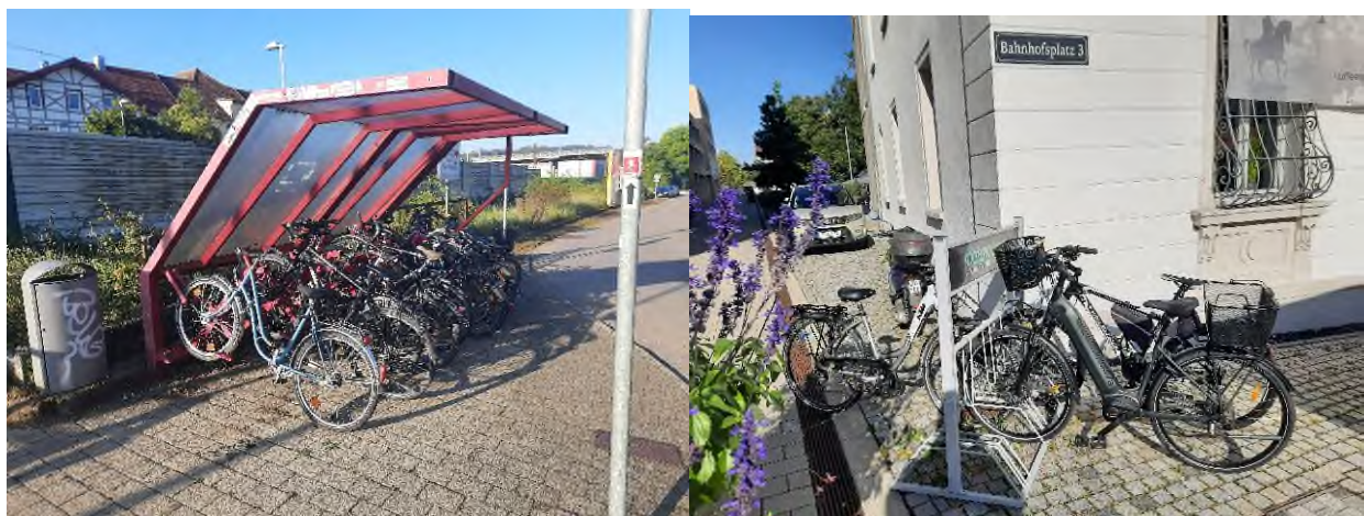
Abbildung 2-1: Beispiele für einfache Vorderradhalter an den Bahnhöfen in Udingen (links) und Göppingen (rechts) (Planungsbüro VIA 202)
