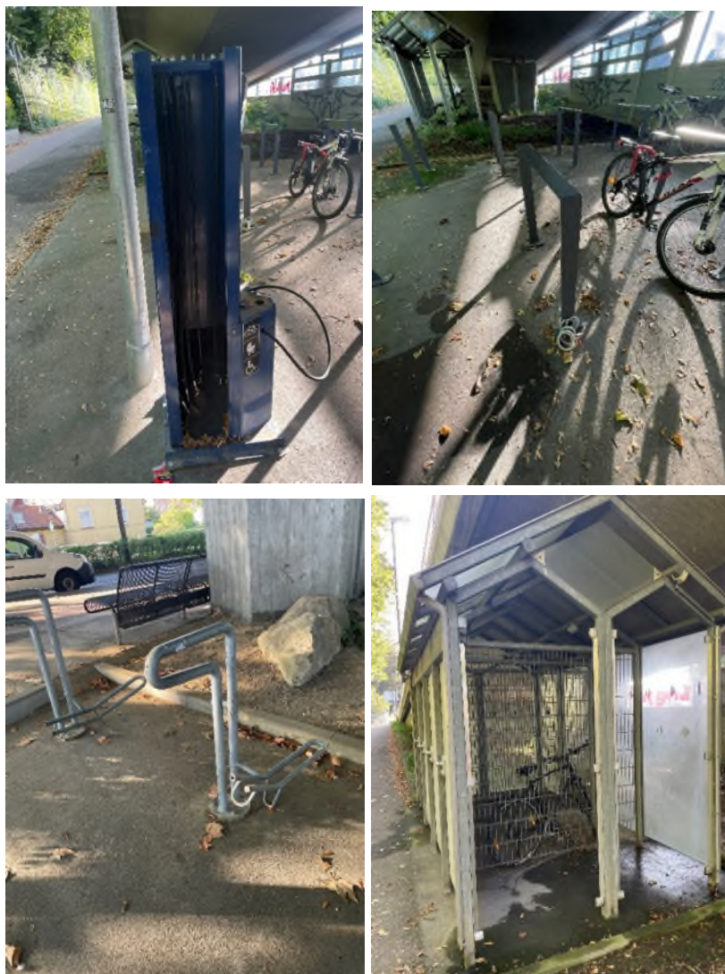
Abbildung 3-8: diverse Schäden an Abstellanlagen am Haltepunkt GP-Faurndau
