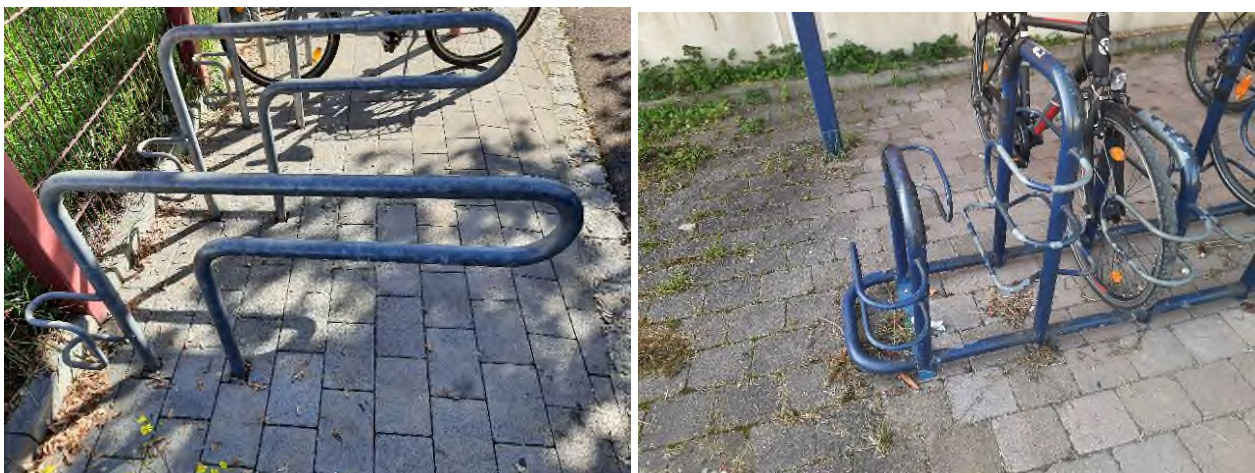
Abbildung 2-3: Anlehnhalter mit Vorderradanschlussmöglichkeit an den Bahnhöfen in Salach (links) und Ebersbach an der Fils (rechts) (Planungsbüro VIA 2023)
