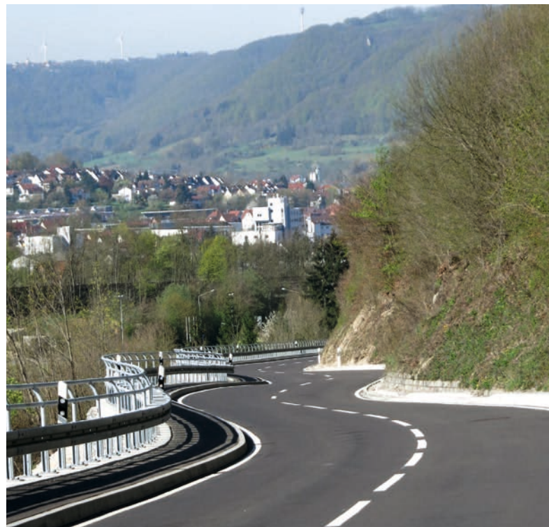
K 1400 Sanierung Stöttener Steige 2. Bauabschnitt 2013 bis 2015
