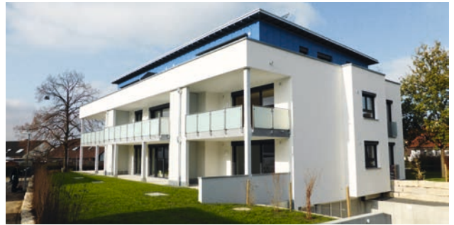
Schlierbach, Daimlerstraße, Neubau Mehrfamilienhaus mit 8 Wohnungen
