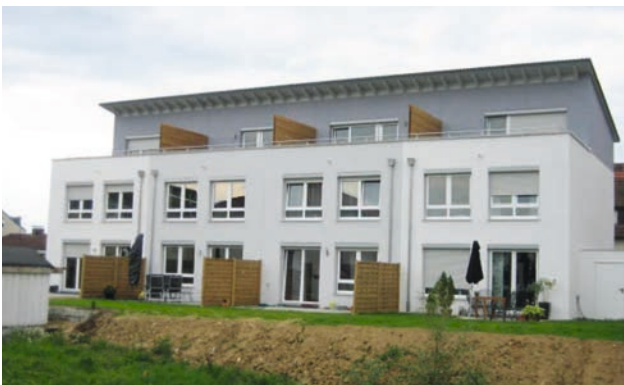
Salach, Zeppelinstraße, Neubau 4 Reihenhäuser
