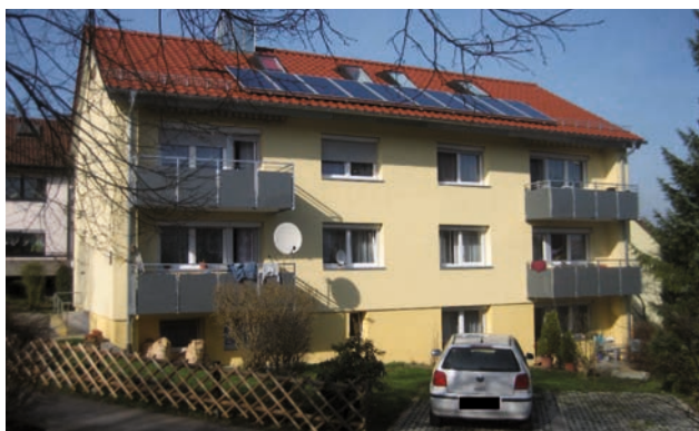
Objekt Ebersbach-Sulpach, Tannenstraße 44
