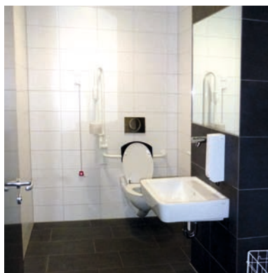
Vorher / Nachher: Sanierung der Sanitärräume im „Hochhaus“ des Landratsamts 2010 bis 2012.
