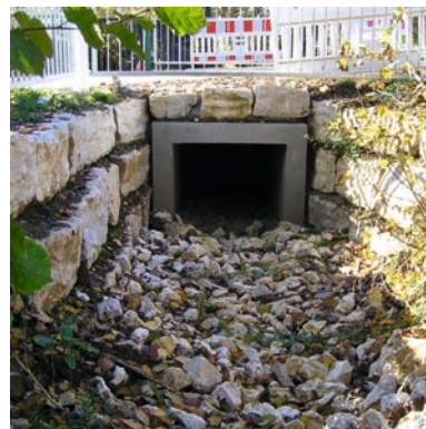
Flurbereinigung Salach (Pfaffhalde): Vergrößerte Durchlässe erleichtern die Wanderung von Tieren im Gewässer.
