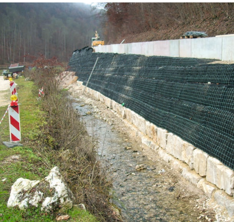
Böschungsaufbau „bewehrte Erde“ an der K 1449 / Sanierung Roggentalstraße 1. Bauabschnitt 2011
