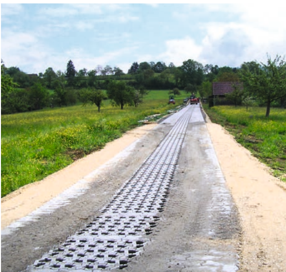
Flurbereinigung Donzdorf: Pflasterspurwege passen sich besser in eine bewegte Topographie ein und sind ökologisch vorteilhafter als Asphaltwege.
