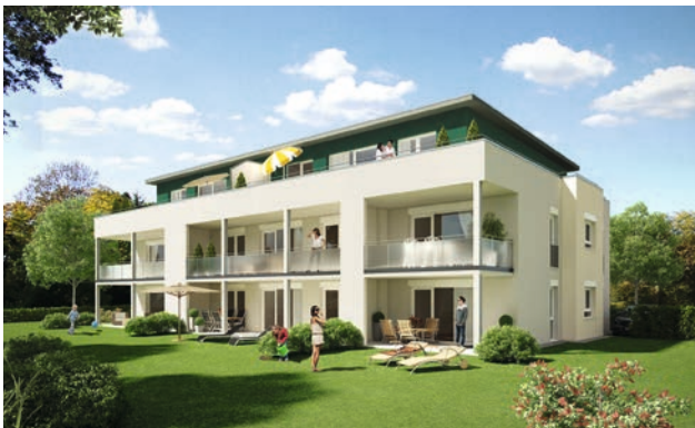
Wäschenbeuren, Heuhofstraße, Neubau Mehrfamilienhaus mit 8 Wohnungen
