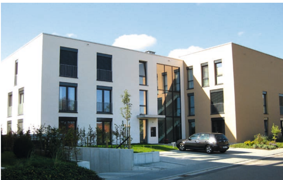
Bad Boll, Seilerstraße, I. BA, Neubau Mehrfamilienhäuser mit 21 Wohnungen
