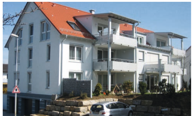
Bad Boll, Freibadweg, Neubau Mehrfamilienhaus mit 8 Wohnungen
