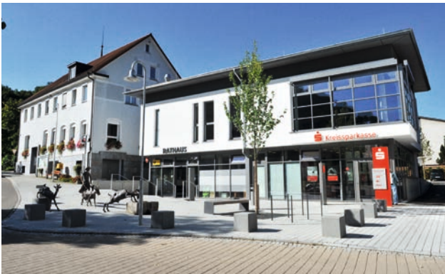
Bad Ditzgenbach, Hauptstraße, Neubau Rathausanbau
