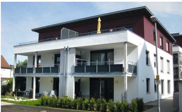
Salach, Ufer-/Lippstraße, Neubau Mehrfamilienhäuser mit 14 Wohnungen
