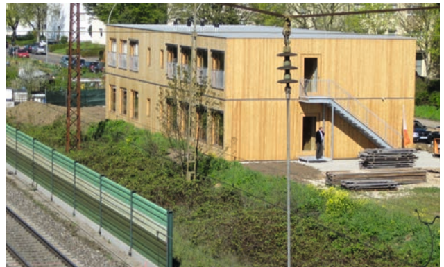
Uhingen, Eisenbahnstraße, Neubau Erstunterbringungsunterkunft
