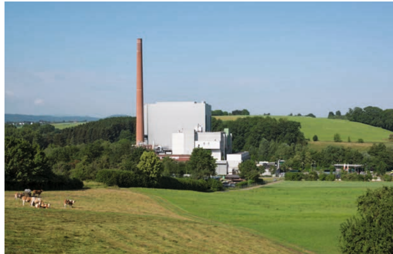
Das Müllheizkraftwerk (MHKW) in Göppingen und Eindrücke aus dem dortigen Betrieb.
