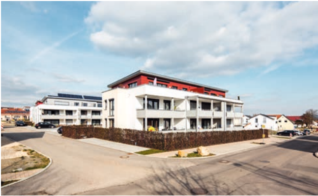
Heiningen, Clara-Schumann-Straße, Neubau Mehrfamilienhäuser mit 23 Wohnungen
