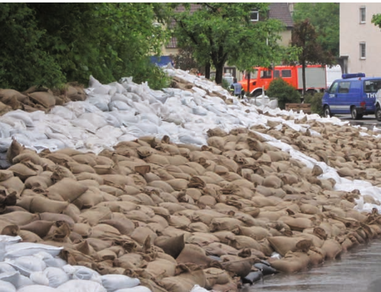
Tausende Sandsäcke sichern den Filsdamm in Bad Überkingen beim Hochwasser 2013
