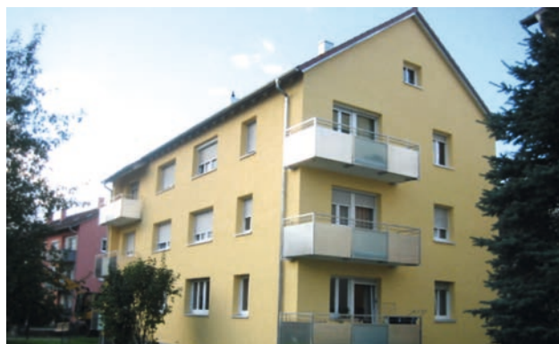
Objekt Eislingen, Lindenstraße 15 + 19
