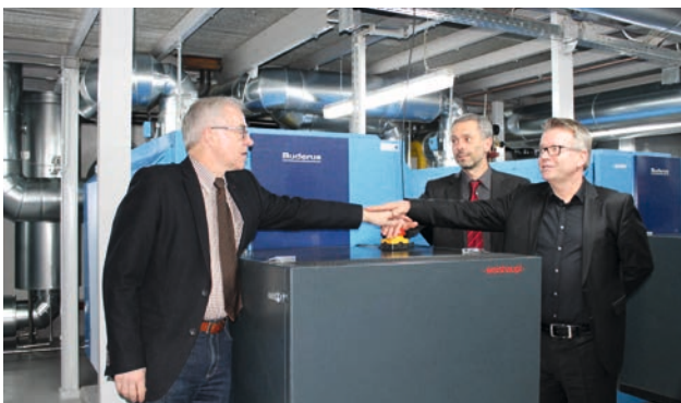
Landrat Edgar Wolff und die Geschäftsführer der ALB FILS KLINIKEN, Wolfgang Schmid und Dr. Jörg Noetzel (von links), nehmen das Blockheizkraftwerk in Betrieb.
