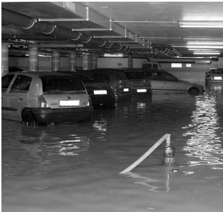
Überflutete Marktplatz-Tiefgarage in Göppingen
