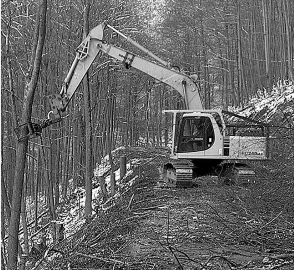
Spezial-Bagger zur Unterstützung beim Fällen am Steilhang
