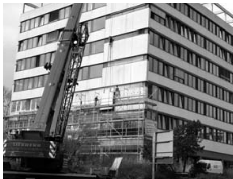
Landratsamt Fassadensanierung – Demontage der Beton-Fertigteilplatten
