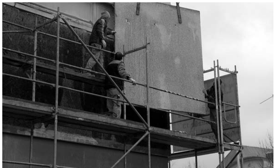
Landratsamt Fassadensanierung – Demontage der Beton-Fertigteileplatten
