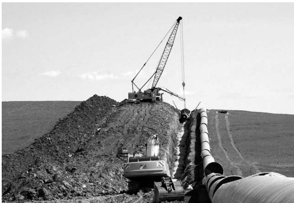
Rohrverlegung nach ausgehobener Trasse
