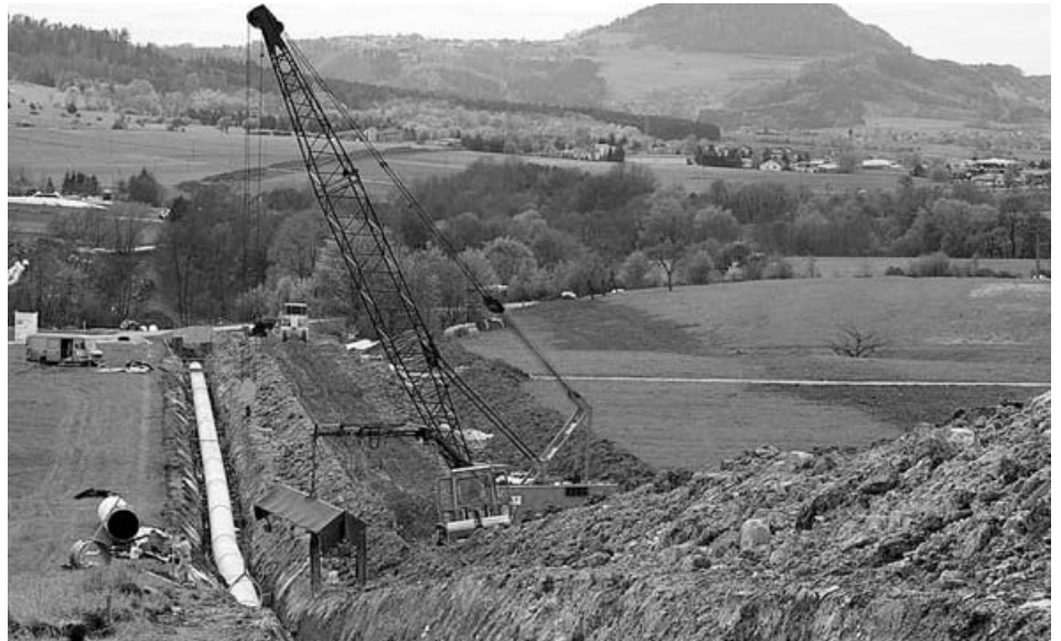
Rohreinbau durch Fachfirma
