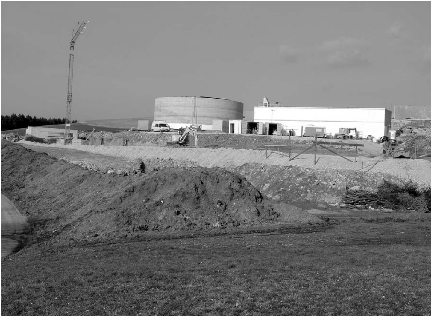
Baustelle mit den Fermentern im Hintergrund
