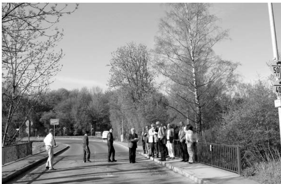
Besichtigung der Heimbachbrücke in Faurndau
