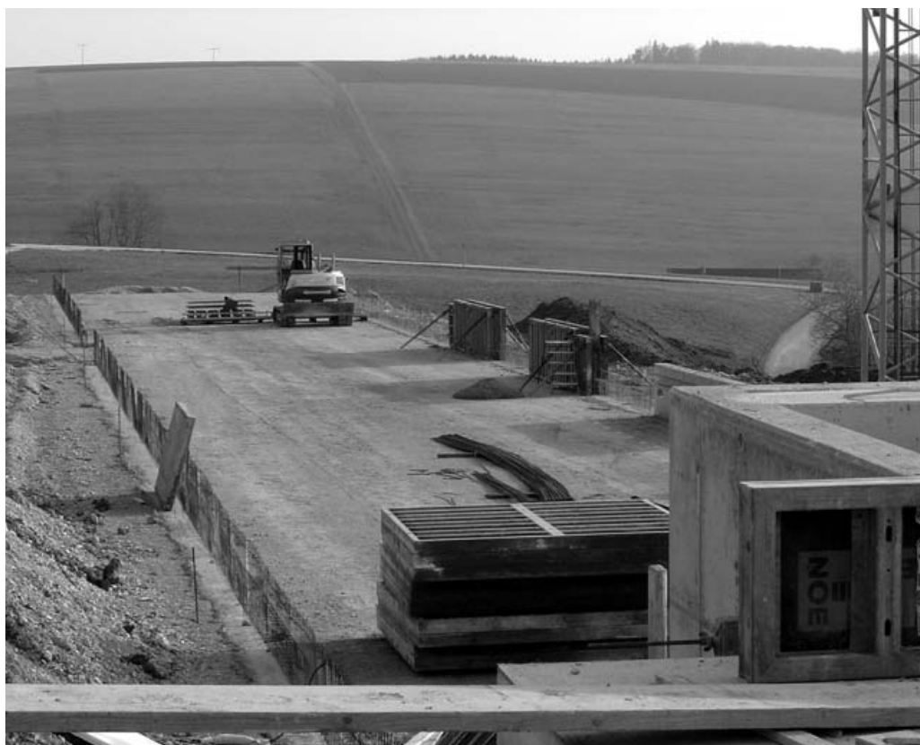
Errichtung des Fundaments für die Klärschlamm-trocknungsanlage
