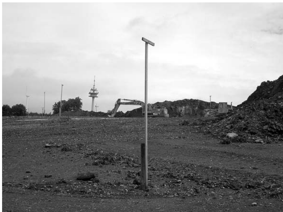
Lattenprofile markieren die Endhöhe der Profilierungsschicht.
