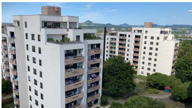
Wohnanlage Göppingen-Bergfeld, Dr.-Pfeiffer-Straße 74, 76 und 78
