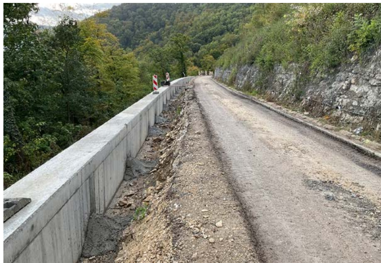
Bau der neuen Kopfbalken zur Sicherung der Steige
