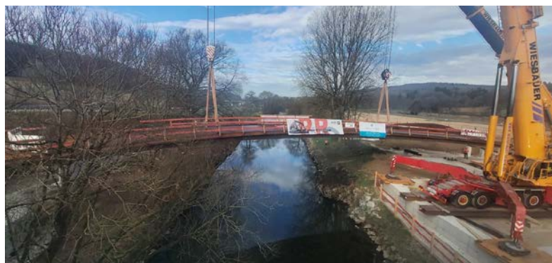
Einheben der neuen Brücke
