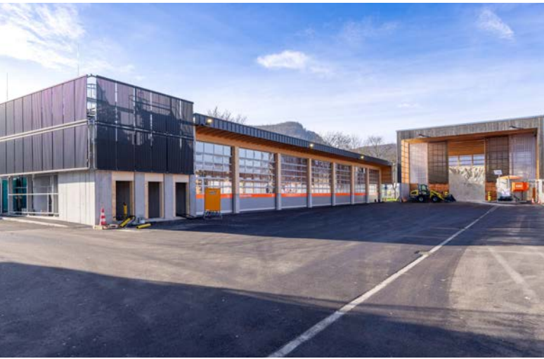
Straßenmeisterei Geislingen mit Lagerhallen
