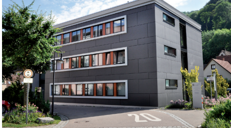
Tagesklinik Geislingen in der Schillerstraße 31
